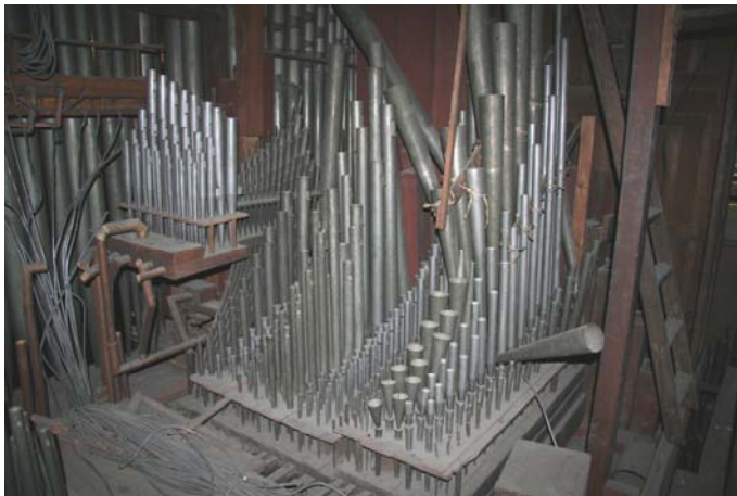
La tuyauterie du Grand Orgue avant ...
